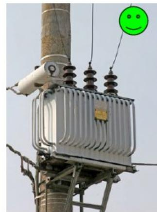
A sx sistemi di attrazione, dissuasione e ingabbiatura e a dx isolatori protetti (da Linee Guida del Ministero dell'Ambiente per la Mitigazione dell'Impatto delle Linee Elettriche sull'Avifauna - Pirovano & Cocchi 2008).
