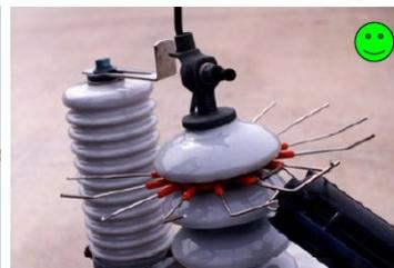
A sx cavo "Elicord" e a dx raggiera di punte metalliche (da Linee Guida del Ministero dell'Ambiente per la Mitigazione dell'Impatto delle Linee Elettriche sull'Avifauna - Pirovano & Cocchi 2008).
